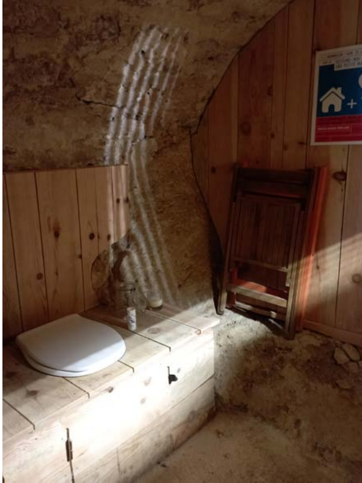
La Maison Forte les toilettes
